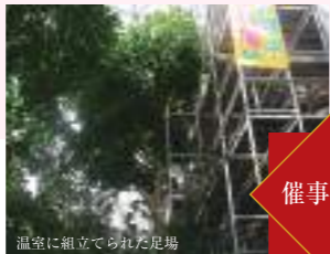
温室に組立てられた足場
