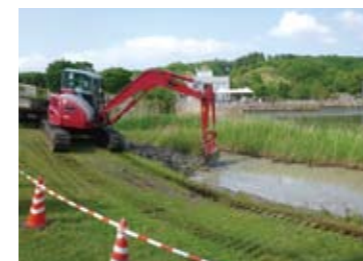
オニバス池を重機で掘り起こしている様子
