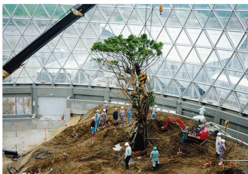
熱帯植物ドーム1番乗りガジュマル搬入の様子(平成9年5月14日)
